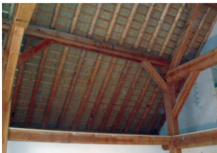
Aan de binnenkant van dit dak is riet gebruikt om te isoleren. Riet heeft een goede isolerende werking maar is tegelijkertijd erg brandbaar.
