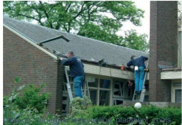
Twee werklieden repareren met open vuur de bitumineuze dakbedekking van dit huis. Het is van belang dat onbrandbaar isolatiemateriaal voor het dak is gebruikt. Bij de afbeelding wordt nog opgemerkt dat ook de Procedure Brandgevaarlijke Werkzaamheden dient te worden nageleefd.
