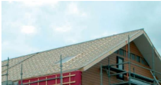
Dakplaten ten behoeve van de woningbouw met daarin het isolatiemateriaal verwerkt (afhankelijk van keuze kunststofschuim of materiaalwol).
