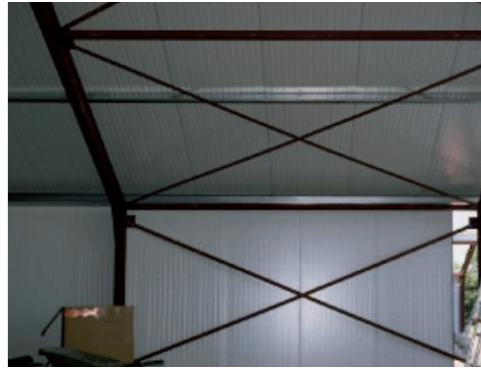
In deze hal wordt voor plafond en wanden gebruikgemaakt van sandwichpanelen: een kern van isolatie aan beide zijden afgewerkt met staal of aluminium. Afhankelijk van de keuze van de isolatie, afdichting en wijze van bevestiging kan een bepaalde brandwerendheid gerealiseerd worden.
