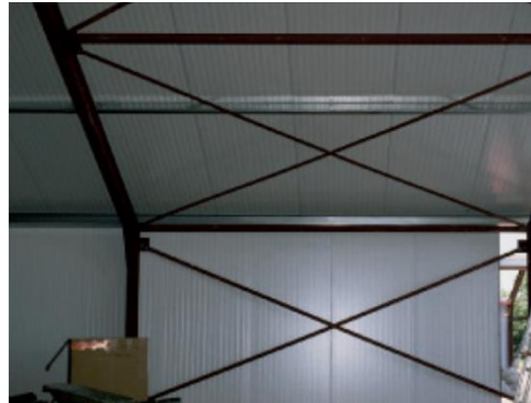
In deze hal wordt voor plafond en wanden gebruikgemaakt van sandwichpanelen: een kern van isolatie aan beide zijden afgewerkt met staal of aluminium. Afhankelijk van de keuze van de isolatie, afdichting en wijze van bevestiging kan een bepaalde brandwerendheid gerealiseerd worden.
