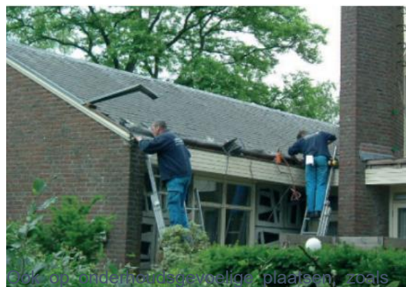
Twee werklieden repareren met open vuur de bitumineuze dakbedekking van dit huis. Het is van belang dat onbrandbaar isolatiemateriaal voor het dak is gebruikt. Bij de afbeelding wordt nog opgemerkt dat ook de Procedure Brandgevaarlijke Werkzaamheden dient te worden nageleefd.
