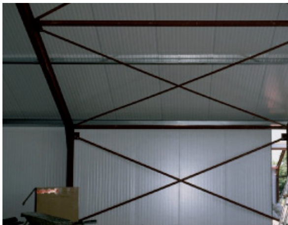
In deze hal wordt voor plafond en wanden gebruikgemaakt van sandwichpanelen; een kern van isolatie aan beide zijde afgewerkt met staal of aluminium. Afhankelijk van de keuze van de isolatie, afdichting en wijze van bevestiging kan er een bepaalde brandwerendheid gerealiseerd worden.
