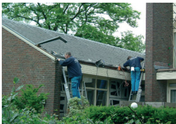
Twee werklieden repareren met open vuur de bitumineuze dakbedekking van dit huis. Het is van belang dat onbrandbaar isolatiemateriaal voor het dak is gebruikt.
