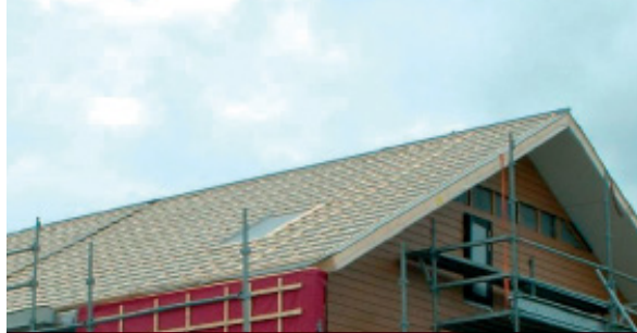
Dakplaten t.b.v. de woningbouw met daarin het isolatiemateriaal verwerkt (afhankelijk van keuze kunststofschuim of mineraalwol).
